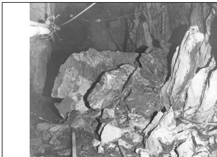
Рис. 1. Обрушения в горных выработках Верхнего оловорудного месторождения в Приморье.
