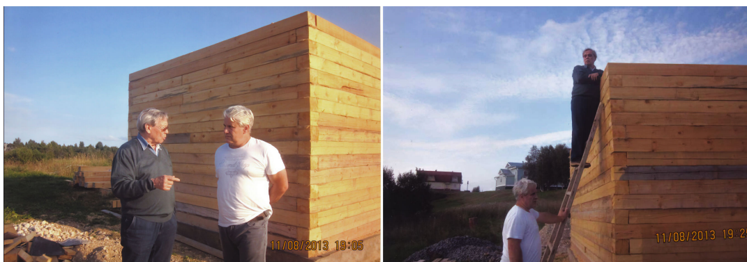
Рис. 2: Акад. РАН Н. П. Лавёров и д.ф.-м.н. А. В. Хохлов при строительстве обсерватории «Климовская» в 2013 году.
